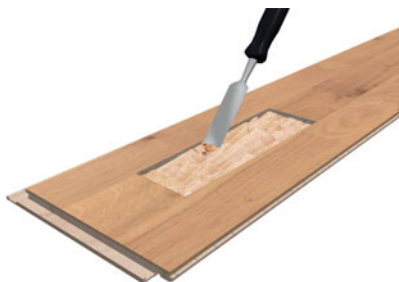
С помощью стамески выдолбите плашку и 2 мм промежуточного слоя.
