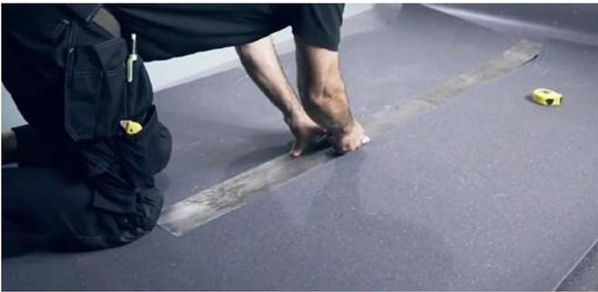
Anschließend wird eine Bahn in Längsrichtung zur Hälfte zurückgeschlagen. Anhand der noch liegenden Bahn wird nun die Nahtstelle markiert (Leitlinie). Danach werden die restlichen Bahnen zur Hälfte umgeschlagen.
