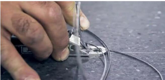
Kährs Infinity Bodenbeläge werden mit einer Temperatur von ca. 500 °C und entsprechendem Schweißgerät verschweißt.
