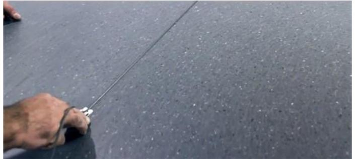
Das Abstoßen der Schweißschnur erfolgt in zwei Arbeitsschritten mit dem Mozart-Abstoß-Messer oder dem Viertelmondmesser. Das erste Abstoßen mit Distanzschlitten wird unmittelbar nach der Verschweißung durchgeführt.
