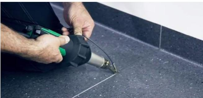
Anpressdruck, Geschwindigkeit sowie die optimale Schweißtemperatur werden vorab durch Testverschweißungen ermittelt.
