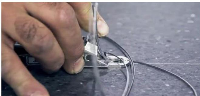
Kährs Infinity Bodenbeläge werden mit einer Temperatur von ca. 500 °C und entsprechendem Schweißgerät verschweißt.
