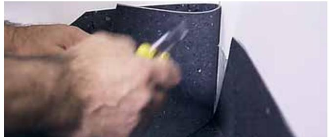
Das überlappende Material sollte erst nach Abkühlen des Bodenbelags entlang der Dreieckskante passgenau zugeschnitten werden.
