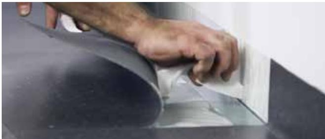
Anschließend den Bodenbelag mit einem Kombi-, Eckroller oder einem Hammer fest in die Ecke zwischen Wand und Boden andrücken. Gegebenenfalls mit dem Heißluftföhn nachwärmen.
