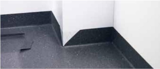
Nach dem Verkleben beider Seiten und Abkühlen des Belags wird ein Dreieck zugeschnitten, unter Wärmezufuhr um die Außenecke gedrückt und passgenau zugeschnitten.
